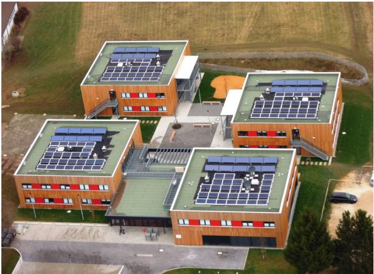
Im vergangenen Jahr 2020 erzeugte die Photovoltaikanlage auf den vier Häusern eine Gesamtleistung von 27.397 kWh Solarstrom.
