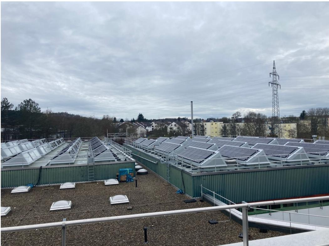
Die Photovoltaikmodule wurden auf der Südseite der Oberlichtkonstruktionen im Dezember 2020 installiert. Die natürliche Belichtung erfolgt über die Fensterscheiben auf der Nordseite. Somit wird auch ein starker Hitzeeintrag auf der Südseite in die Werkstatträume vermieden.
